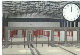
Sedan byggs formen och fylls kontinuerligt med betong. Varje segment tar 24 timmar att gjuta. Betongen hårdnar i 72 timmar. Åtta segment bildar ett 178 meter långt element.
